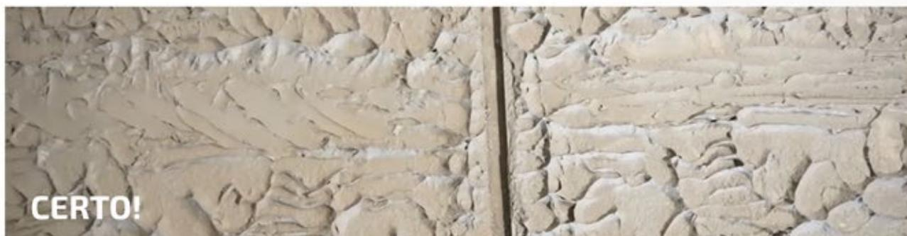
Exemplo de aplicação correta, com dupla camada de argamassa e pressão suficiente nas batidas, causando o esmagamento dos cordões e máxima aderência.
