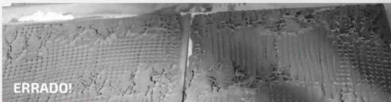
Exemplo de aplicação errada, com dupla camada de argamassa, porém sem pressão suficiente nas batidas para garantir o correto esmagamento dos cordões.
